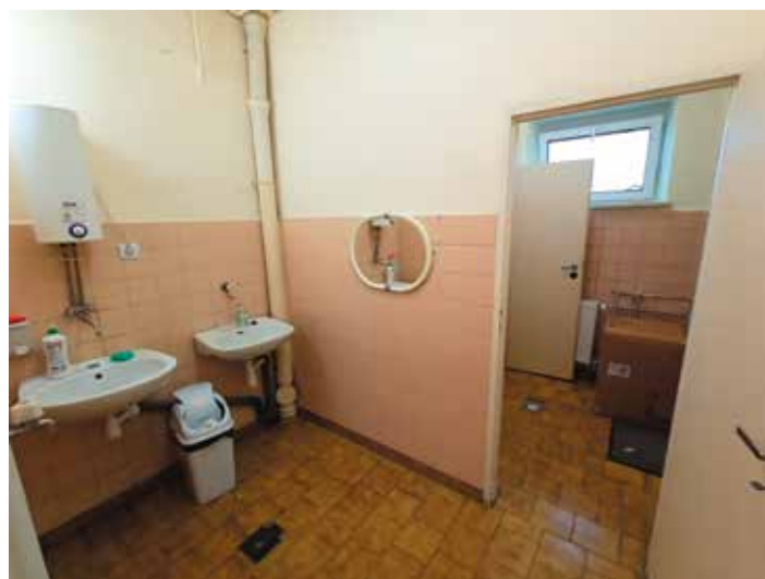
Przed remontem łazienki
